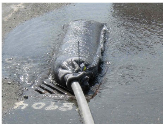
Túi lọc nước trước đầu vào của bơm
