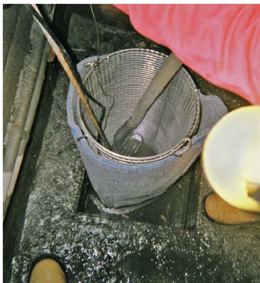
Túi lọc nước trước đầu vào của bơm
