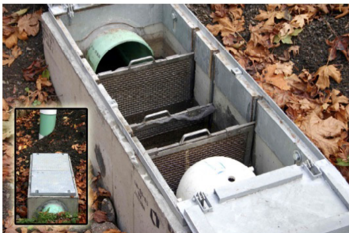
Vải lọc kẹp vào khung cố định chắn ngang cống thoát nước
